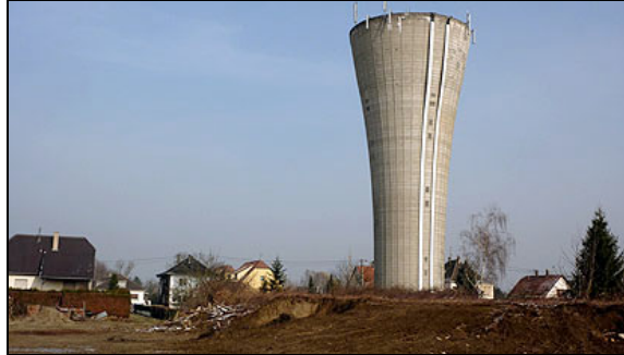
Château d'eau contemporain en béton armé de taille imposante (plus de 40 mètres de hauteur).
