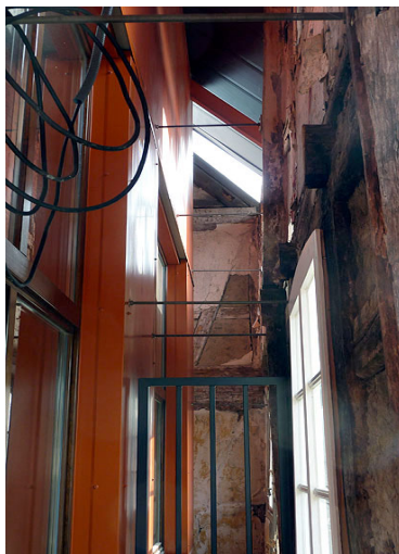
Espace vide situé entre les deux parois du bâtiment
